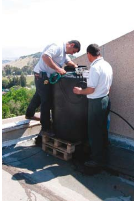
התקנת מיכל על גג הבניין
