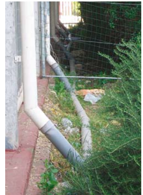
חלק ממערכת הניקוז - צינורות שבאמצעותם אוספים את מי-הנגר מהמרזבים*
