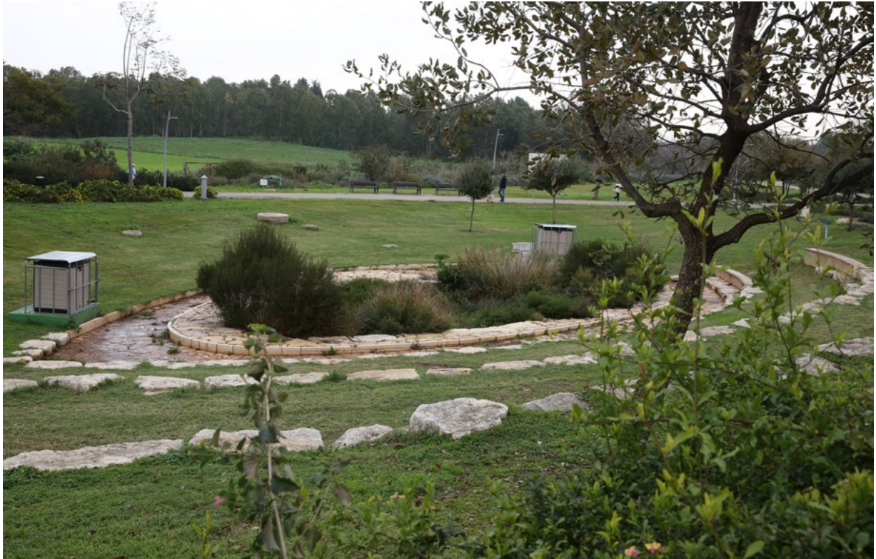
ביופילטר, פארק 80: מטרה מי נגר ממתכות כבדות, חיידיקים ומוצקים מרחפים. המתקן קולט עשרות אלפי קוב בשנה המוחדרים למי התהום. צילום: יוסי זמיר.
